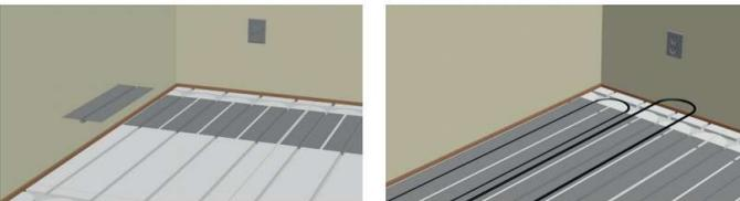
4. Verlegen Sie die Trockenestrichplatten (Gipsfaserplatte.) mit Kleber und verbinden Sie sie Kante an Kante. Der so verlegte Untergrund darf 24 Stunden lang nicht betreten werden. Entfernen Sie Klebstoffreste und grundieren grundieren Sie die Oberfläche.
