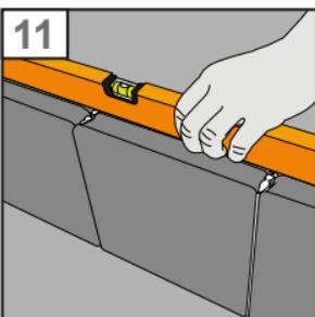
11. Wenn die erste Reihe fertig ist, prüfen Sie mit einer Wasserwaage, ob die Steine gerade sind. Solange der SRT Montagekleber noch nicht getrocknet ist können Sie leichte Korrekturen an der Wand vornehmen.
