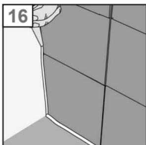
16. Do uszczelniania połączeń stawów między podłogi, bloku i ściany, użyj dobrego silikonu.
