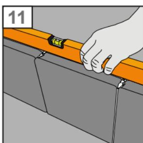
11. Après le montage de la 1ère rangée, vérifiez l'aplomb et faites des corrections si nécessaire tant que le liant n'est pas encore sec.
