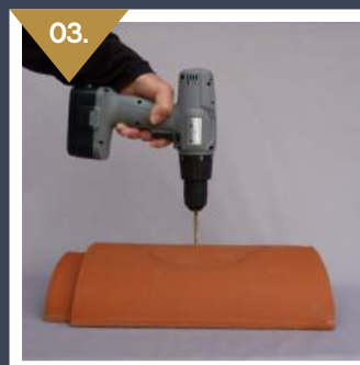
03. Bohren mit Steinbohrer 6 bzw. 10 mm
