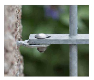
Drehen Sie anschließend die Langlochschrauben ein. Wenn Sie die Langlochschraube mit Mutter und Unterlegscheibe befestigen, sitzt die Langlochschraube fest am Pfosten. Die Mutter muss dafür bis zum Anschlag am Langlochkopf eingedreht werden. Die Ösen sind horizontal ausgerichtet.
