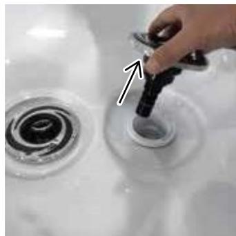
Den neuen Düsen einsetzen und so lange im Uhrzeigersinn drehen, bis der Düsen noch um eine halbe Umdrehung gedreht werden können. Die Düsen dürfen **nicht** zu fest gedreht werden.
