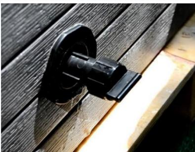
Ziehe die Schraubvorrichtung komplett heraus. In dieser Position entweicht noch kein Wasser. Danach schraube die Abdeckkappe ab.
