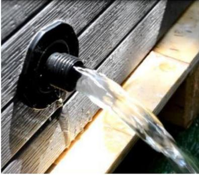
Erst wenn der Schraubverschluss in Richtung Schürze gedrückt wird, beginnt das Wasser abzulaufen. Das Verschließen des Ablaufs erfolgt in umgekehrter Reihenfolge.
