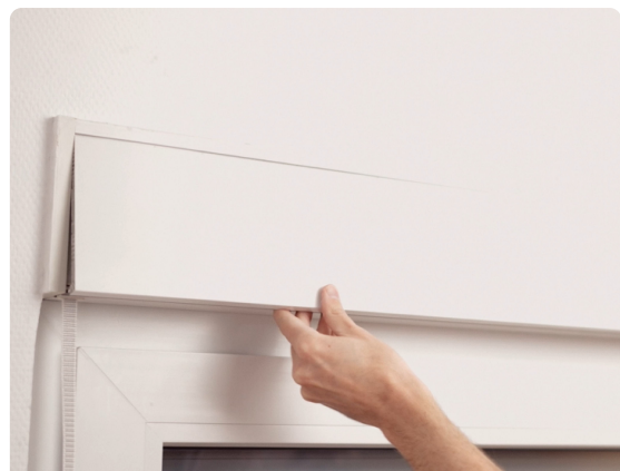
10. Rollladenkasten schließen
