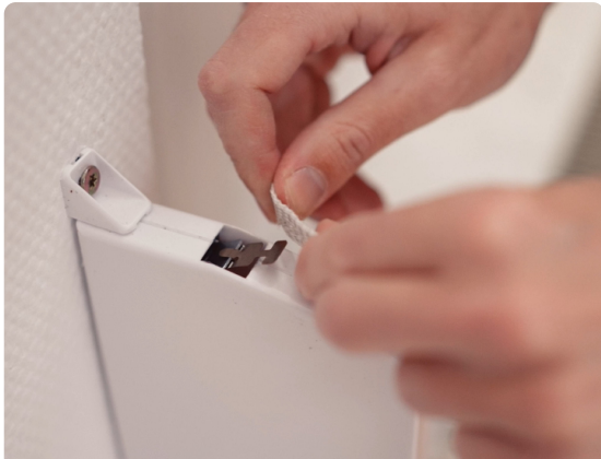
7. Rollladengurt einfädeln
