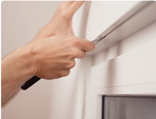
3. Rollladenkasten öffnen
