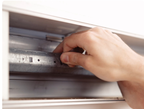
4. Befestigungsfedern aushängen
