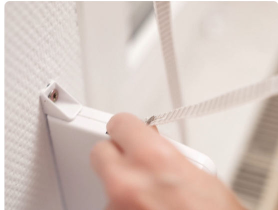
8. Gurtband gerade einziehen lassen
