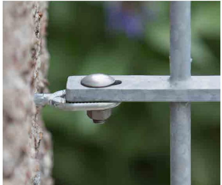
Drehen Sie anschließend die Langlochschauben ein. Wenn Sie die Langlochschaube mit Mutter und Unterlegscheibe befestigen, sitzt die Langlochschaube fest am Pfosten. Die Mutter muss dafür bis zum Anschlag am Langlochkopf eingedreht werden. Die Ösen sind horizontal ausgerichtet.
