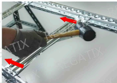
Die Traversen/Diagonalen sollten abwechselnd (links / rechts) eingeschlagen werden, um ein Verkanten zu vermeiden.
