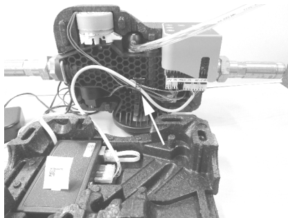
Afb. 8: Plaats de verbindingkabel in de kabelbinder
